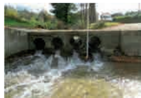
Passage à Gué Champestève, Buses empêchant la circulation de débris et de poissons
