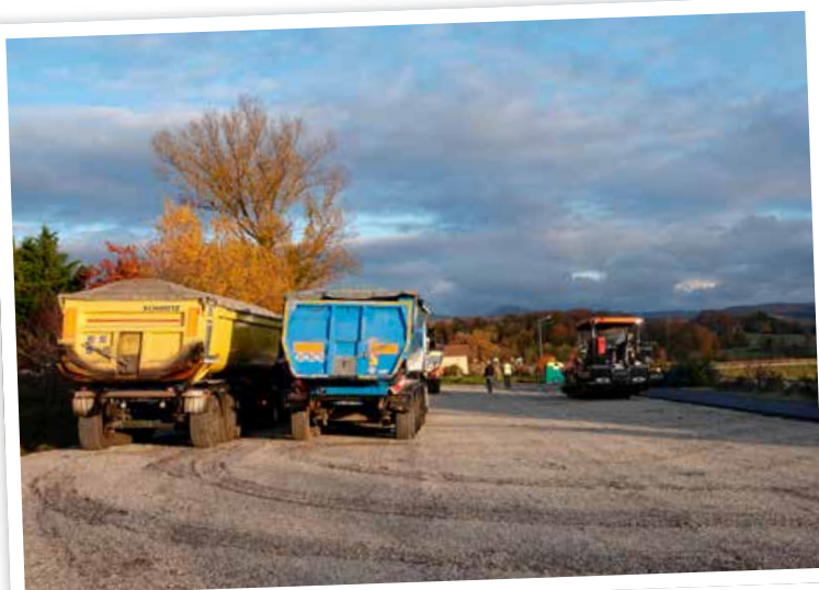
Travaux de goudronnage du parking sous le village
