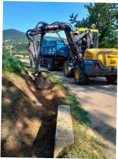
Curage des fossés entre quartier Brémonde et les Chaix
