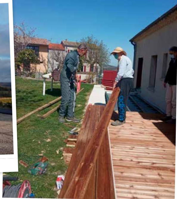
Rénovation de la terrasse du logement de l'ancienne poste
