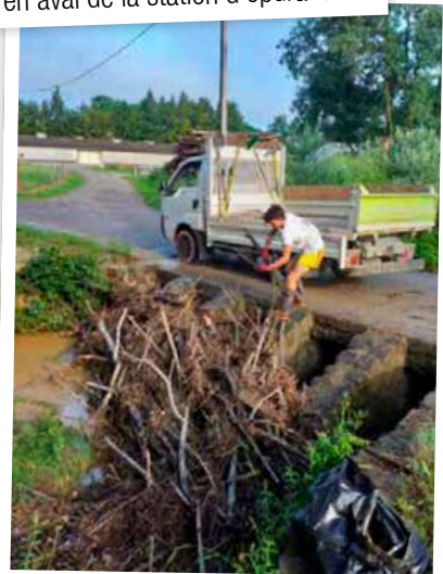
Nettoyage du pont aux Pontillons après la crue
