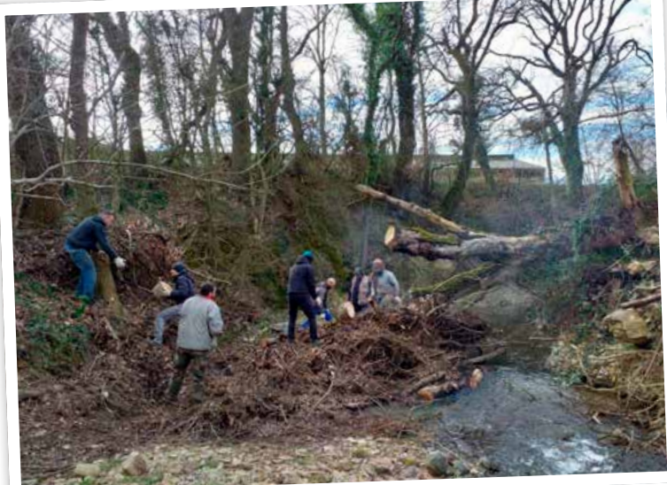
Brigades vertes-nettoyage de l'Ozon en aval de la station d'épuration
